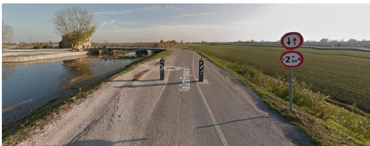
Figura 5 - via Corte Fogolana - innesto con zona delle chiuse
