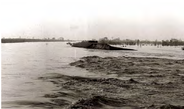
Figura 2-3: Alluvione del 1966 - Rotta del Brenta a Conche
