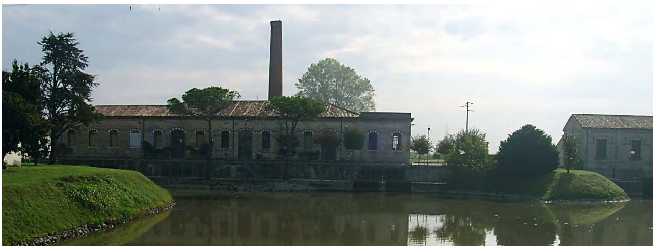
Figura 2-10: Idrovora di S.Margherita – pertinenze
