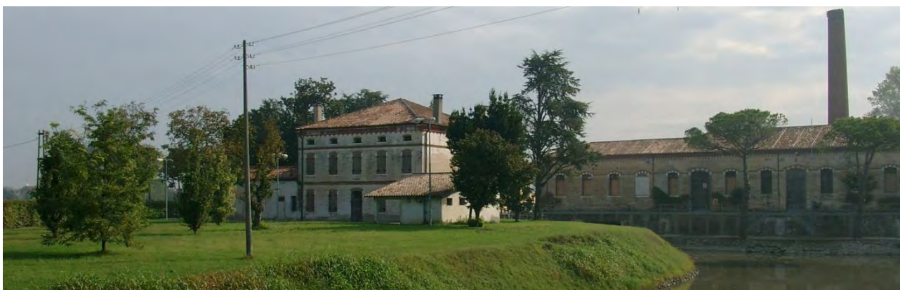
Figura 2-9: Idrovora di S.Margherita – edificio principale
